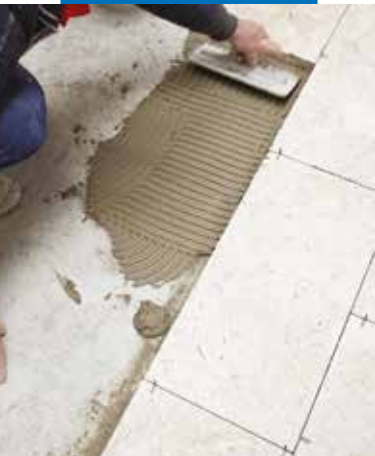
Posa di grès porcellanato con Keraflex Maxi S1 zero
