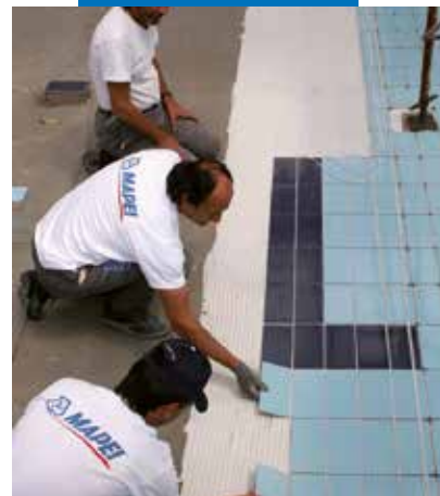
Posa di rivestimento ceramico su Mapelastic
