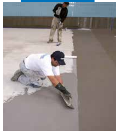
Impermeabilizzazione di una piscina con Mapelastic
