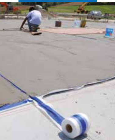
Impermeabilizzazione dei massetti con Mapelastic e Mapeband
