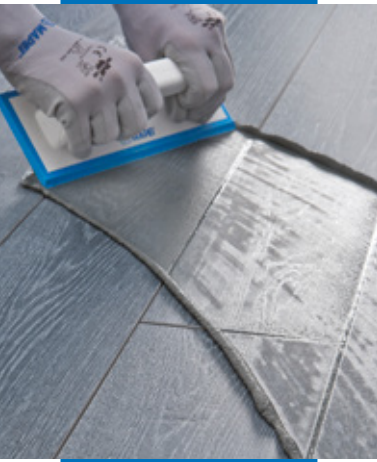
Stesura di Ultracolor Plus a pavimento con spatola di gomma su piastrelle in gres porcellanato effetto legno
