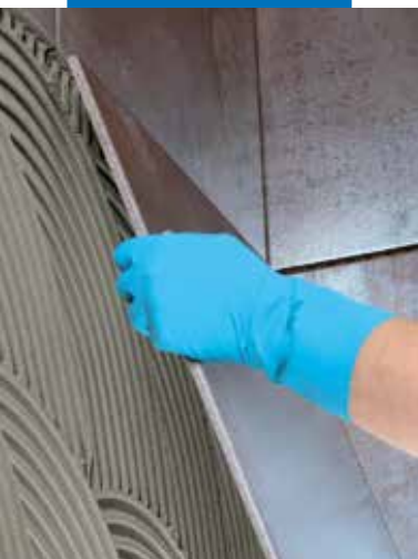
Posa di piastrelle in ceramica di grosso formato a parete
