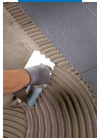
Stesura dell'adesivo a pavimento con spatola con dente arrotondato di raggio pari a 9 mm
