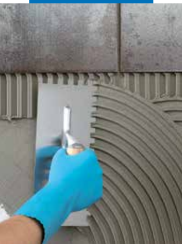
Stesura di Ultralite S1 con spatola dentata a parete
