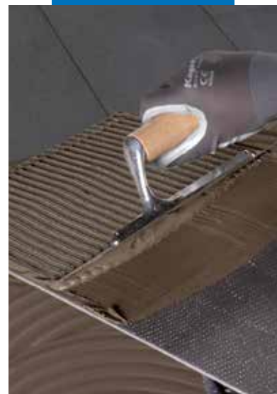
Applicazione dell'adesivo sul retro della piastrella
