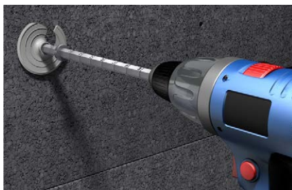
Installazione su diversi spessori di pannello.
